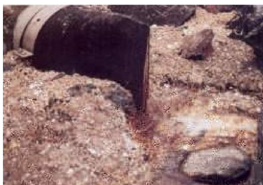
Rückstauklappe TideFlex in Gummi
