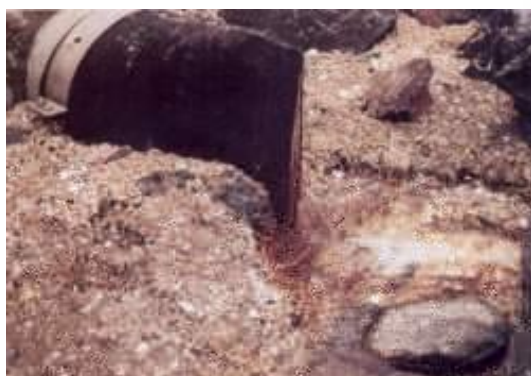
Rückstauklappe TideFlex in Gummi
